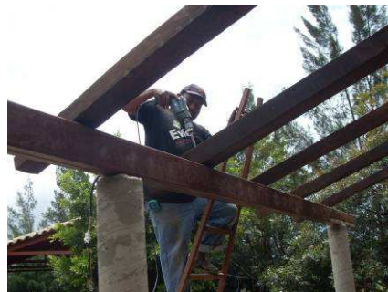
Arbeiten am Vordach des Kindergartens
